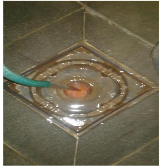
تم تنظيف جميع تصريف المياه الخاص بالممر الأكاديمي وتجربة نزول المياه، وتم ابلاغ الصيانة بالانسدادات لصانتها.
